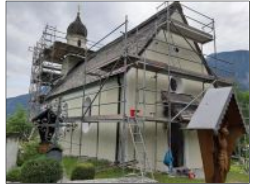
St. Georg während der Renovierung
