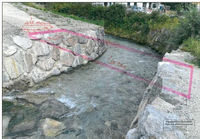
Für dieses Bauwerk wurde eine durch das örtliche Ingenieurbüro Georg Kuba erarbeitete Planung vorgelegt, mit der sich der Gemeinderat am 23. Oktober eingehend befasst hat. Vorgesehen ist eine Stahlprofil-Trägerkonstruktion mit einer Spannweite von ca. 9,8 m, die die Stahlbetonplatte mit einer Breite 2,0 m tragen soll. Die Brückenplatte wird mit einem Asphaltbelag abgedichtet und mit einem Stahl-Geländer (Höhe ca. 1,4
